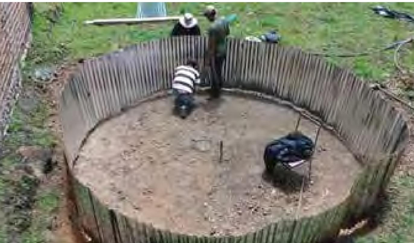
5. Colocar los diez metros de manguera alrededor del tanque para que las puntas no rompan el plástico.
