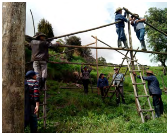
Fotografía 4. Construcción de invernadero, Asociación AHAA, municipio de Mongua
