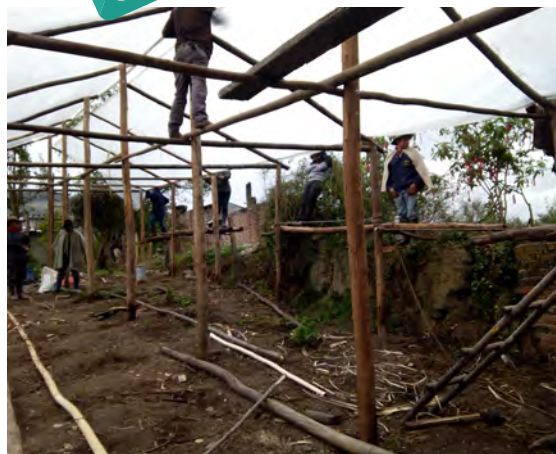
Fotografía 3. Construcción de estructura invernadero, Acueducto de Daita, vereda de Saza, municipio de Gámeza
